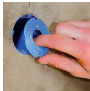
8. Wyrzucić dekielek i puszka gotowa do zamocowania osprzętu (w układzie prostokątnym puszka posiada słupki do wkręcenia śrub osprzętowych).
