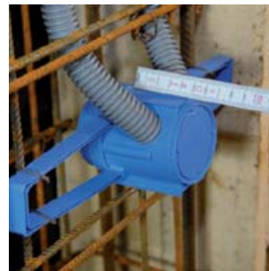
6. Zamocowana puszka pozwala na zastosowanie głębokości betonu do 60 mm.
