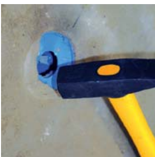
7. Wybić dekielek po wyrównaniu ściany.
